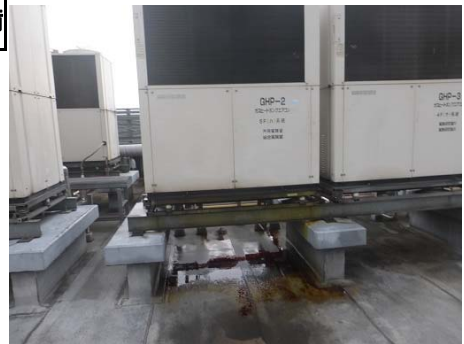
【生体調節研究所】GHP室外機 冷凍機 油漏れ 機械設備B 経年16年
